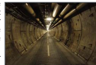
Le tunnel de service
