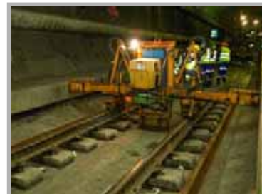
Les nouveaux rails sont positionnés à côté de ceux à remplacer. Une positionneuse écarte les rails à remplacer tout en ramenant le nouveau rail à mettre en place.
