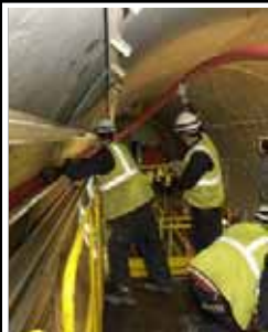
Inst. of 21kV cable
