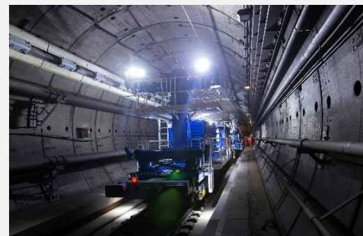
Halage du câble CC dans le Tunnel terminé en mai 2021
