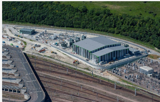
Construction de la station de conversion au Royaume-Uni achevée en 2020 et testée en 2021
