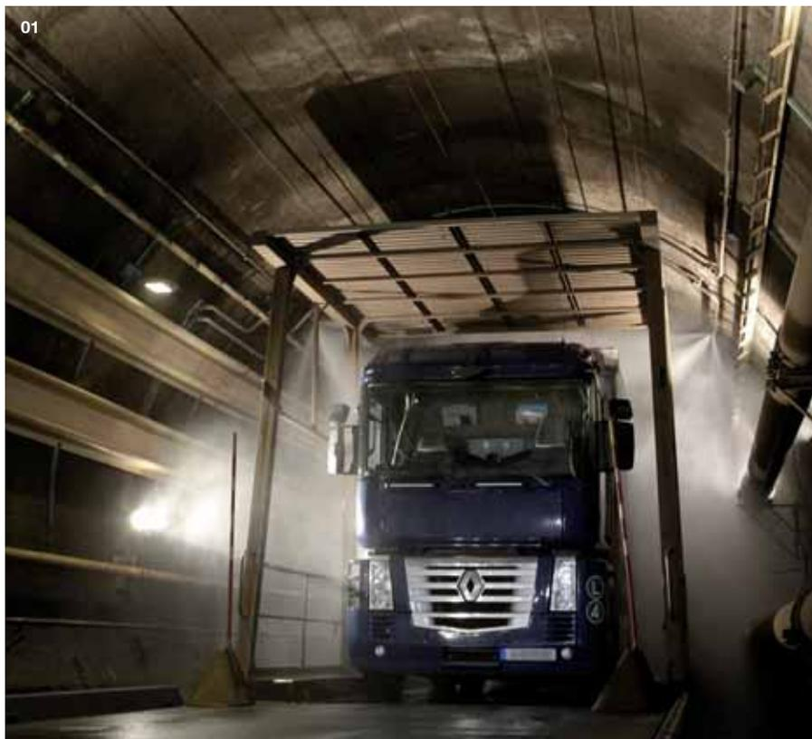
**01** Les stations SAFE projettent sur un point chaud un puissant brouillard d'eau qui « étouffe » un éventuel incendie et empêche sa propagation à d'autres camions
